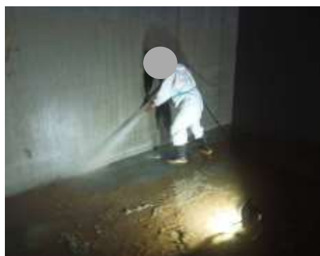
ภาพที่ 2-16 ทำความสะอาดถังเก็บน้ำ
