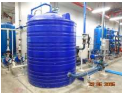
ภาพที่ 2-14 ถังสำรองน้ำใช้ และน้ำสำรองดับเพลิง
